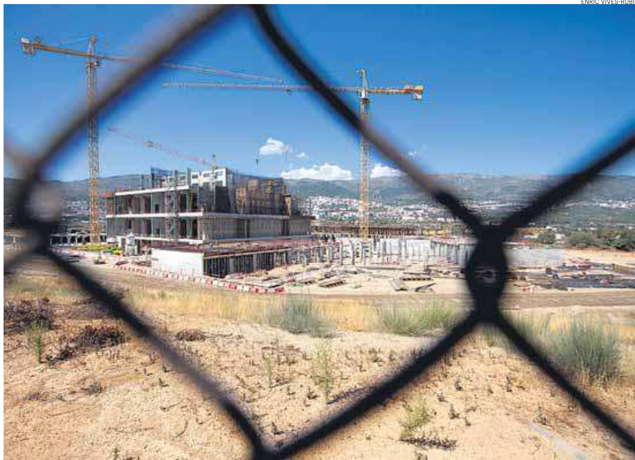
Novo centro de dados da PT está a ser construído em cima da antiga pista da Covilhã
